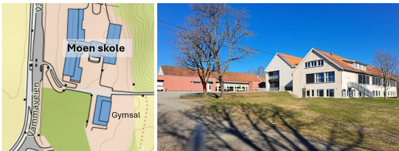
Figur 14: Situasjonsskart Moen skole. Bildet: Skolen sett fra sør. (Foto: Indre Østfold kommune).
