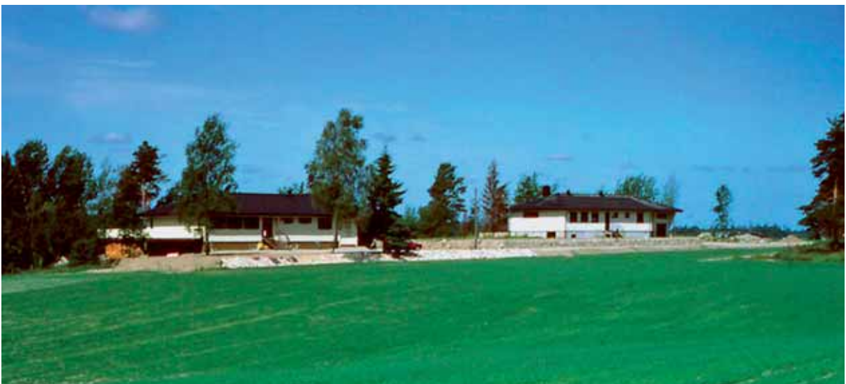
Bolig plassert i kantsonen til jordbruksarealer gir uheldig fjernvirkning. Ved bedre terrengtilpasning med mindre fylling samt annen fargebruk kunne virkningen vært dempet, Skiptvet. Foto: Vidar Asheim
