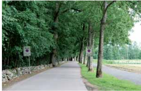
Bevaring av vegetasjon ved fremføring av ny gang- og sykkelvei bak gammel trekke. Jeløy, Moss. Foto: Daniella Wennberg
