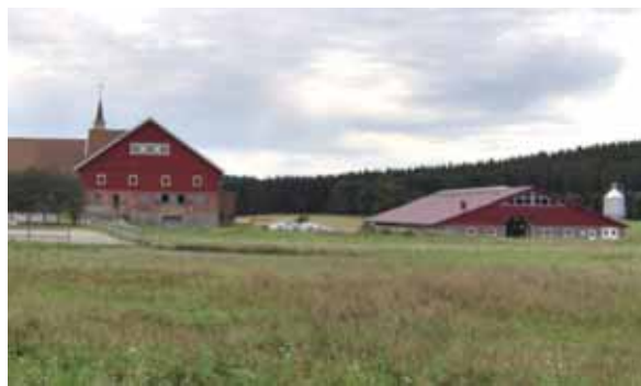
Ny driftsbygning med avvikende dimensjon er tilpasset eksisterende bygninger gjennom fargebruk og detaljering. Thorsø, Fredrikstad. Foto: Øyvind Nordberg
