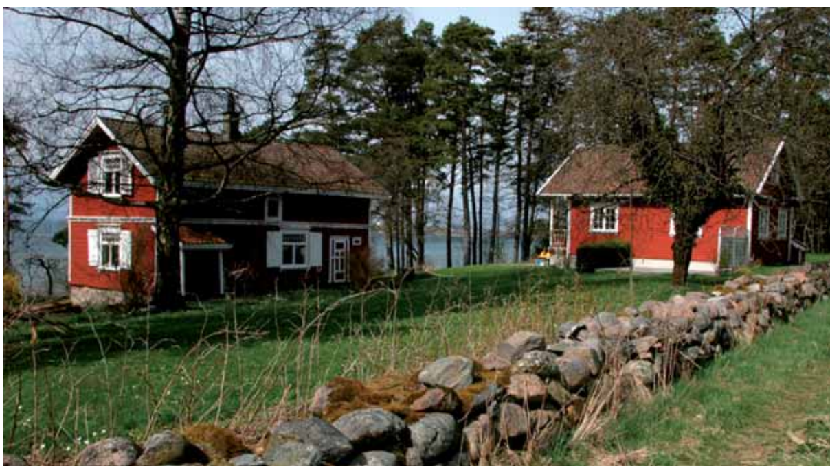
Bra tilpasset spredt utbygging. Ny spredt bebyggelse er tilpasset den gamle bygningen til venstre i formspråk, farge og materialbruk, og bygningene danner et naturlig hele. Ferdselsinteressene er ivaretatt ved at privat område er tydelig avgrenset med et steingjerde som samtidig beriker landskapsbildet. Foto: Oskar Puschmann
