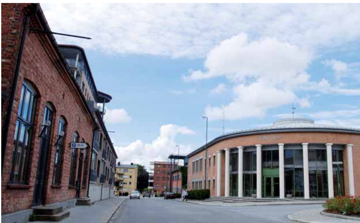
Ny bebyggelse er godt tilpasset eksisterende bystruktur i volum og formspråk, og ved at hjørnet er brutt. Sarpsborg tinghus. Foto: Daniella Wennberg
