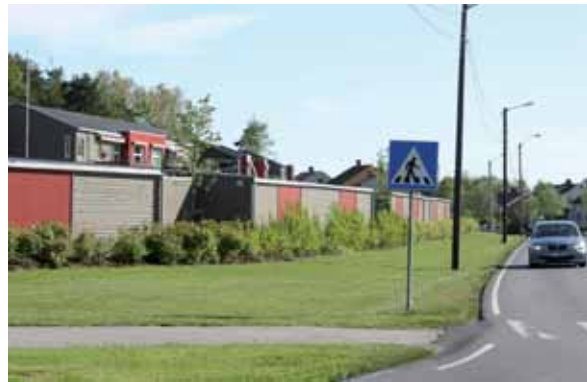
Støyskjermens visuelle virkning er dempet ved bruk av vegetasjon, ved at den er brutt opp og at materialbruk og farger speiler tilstøtende bebyggelse. Foto: Lars Ole Klavestad
