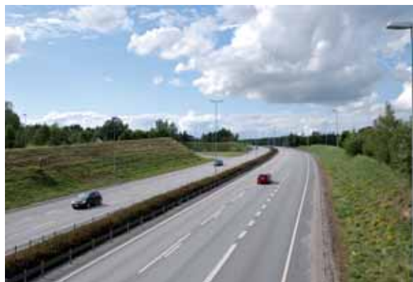
Mye bruk av støyvoll og støyskjerming langs veien an gi korridoreffekt som forringer landskapsopplevelsen, selv om veien er godt utformet. E6 Råde. Foto: Daniella Wennberg
