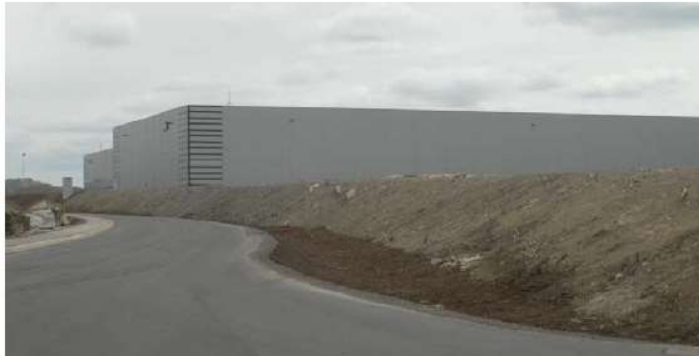
Lager/logistikkbygg på Vestby (Nille) med høyde på 25 m
