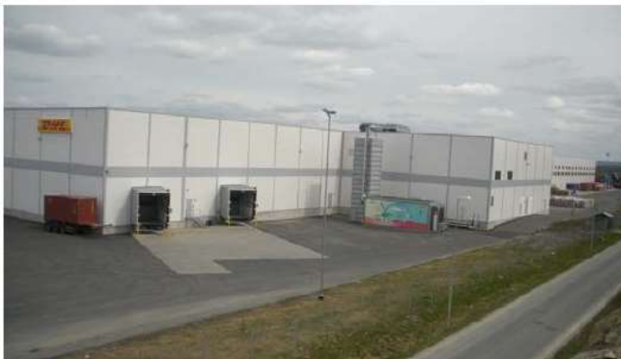
Lager/logistikkbygg på Vestby (DHL) med høyde på 15 m
